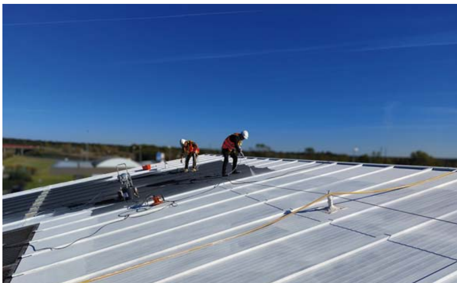
➤ En toiture, la peinture blanche vise à empêcher la chaleur de rentrer dans le bâtiment.
