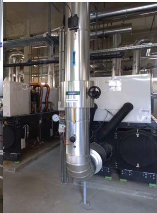
▀ Trois thermofrigopompes, de 1 MW chacune, alimentent l'extension du Futuroscope.
